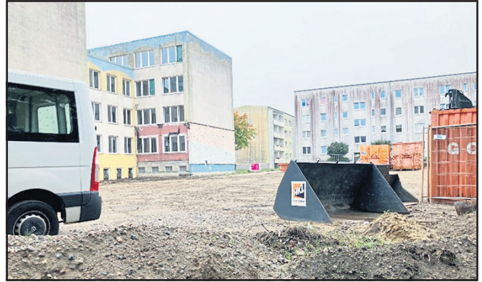
Ostfassade der alten Europaschule mit davorliegendem Baufeld
