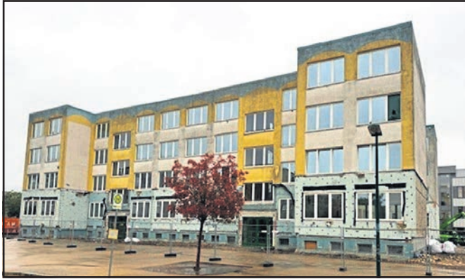
Außenfassade der alten Europaschule „Haupteingangsbereich“
