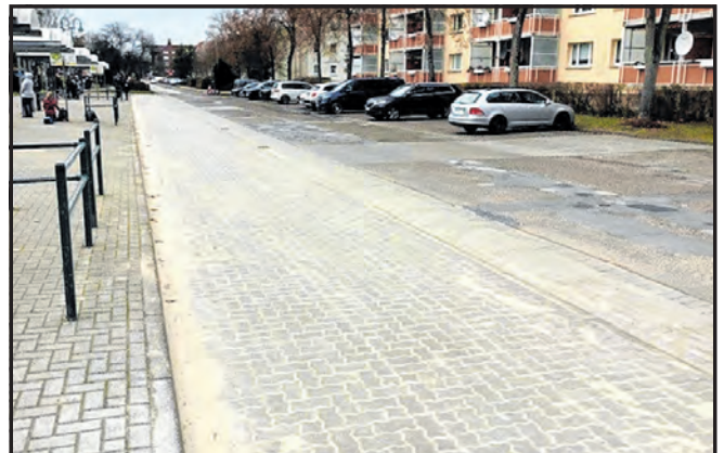
Möllner Straße – Schulzentrum Reparatur Bushaltestelle
